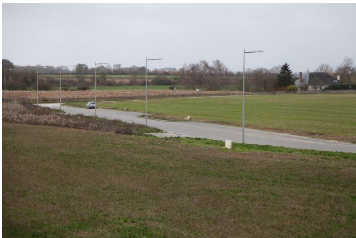
Photo 3 : proximité de l'habitation de la Métairie
